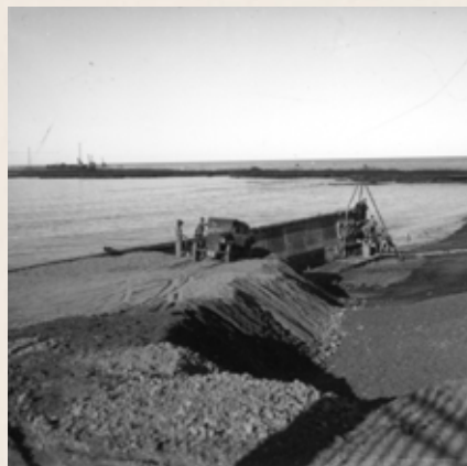
1940. Otro detalle del trabajo de relleno de pedregullo para construir el primer paseo costero de la ciudad en la playa costanera. Fuente: Fototeca Comodoro Rivadavia.
